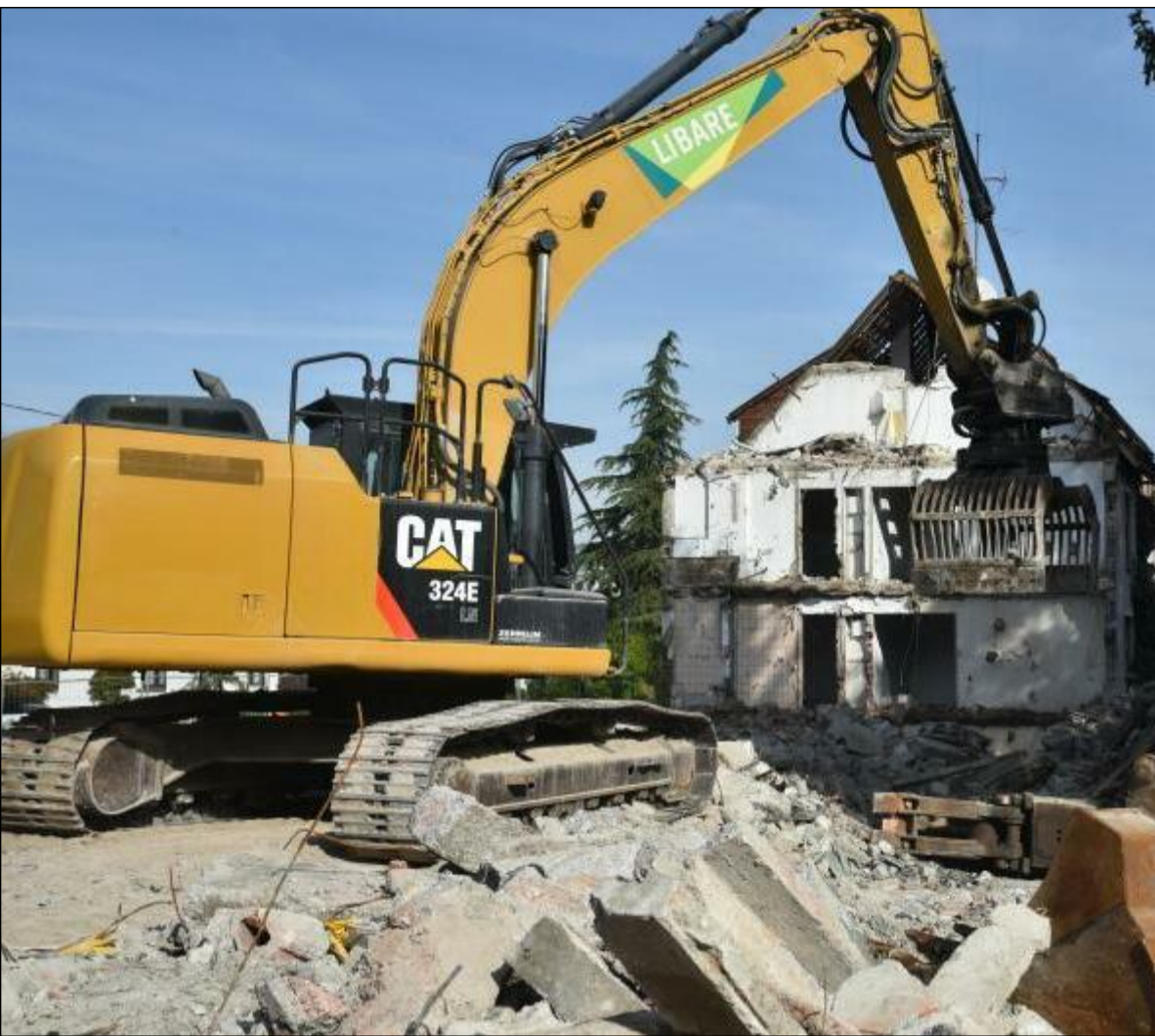
Aus alt wird neu: Der Bagger beim Abriss der fünf Häuser in der Erlenstraße und in der Weidenstraße. Geplant sind dort wieder fünf Häuser, auf einer Tiefgarage.
