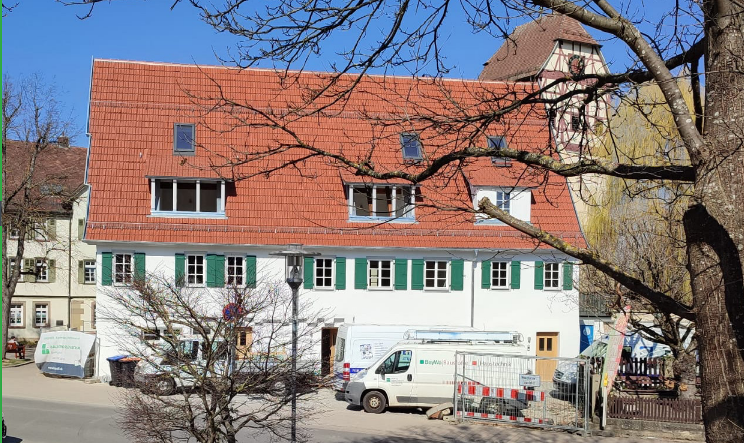
Bauvorhaben Widdumhof, Sindelfingen-Maichingen
