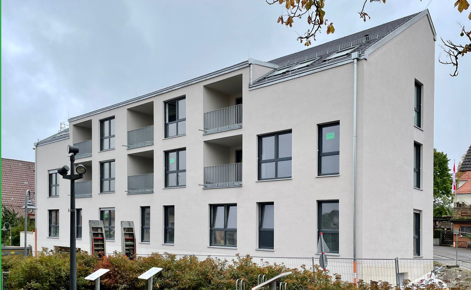
Ostansicht von der Schlossgartenstraße, Mötzingen
