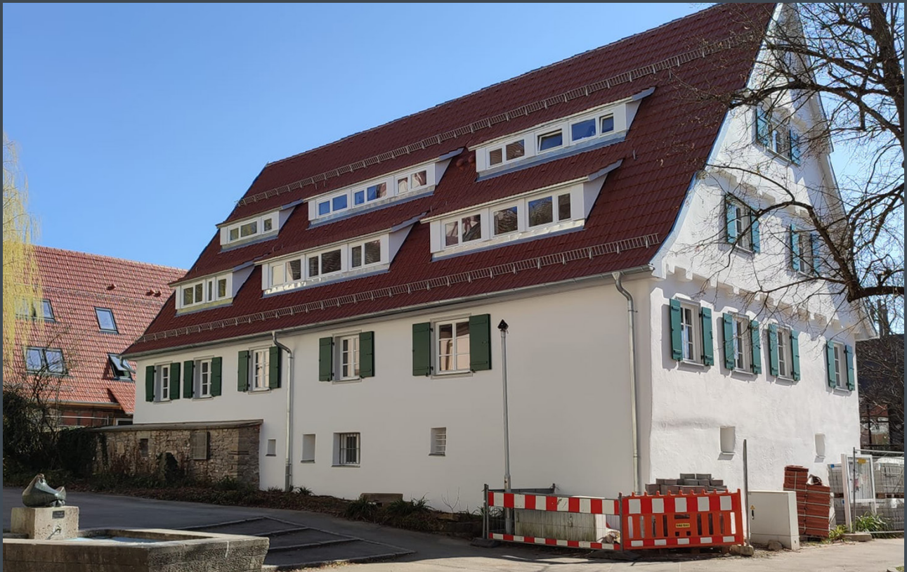
Bauvorhaben Widdumhof, Sindelfingen-Maichingen
